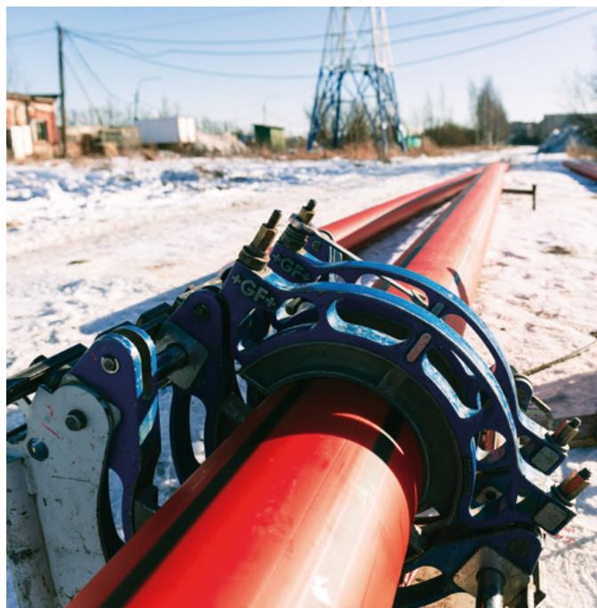
Процесс стыковой сварки труб ПРОТЕКТОРФЛЕКС® БК
