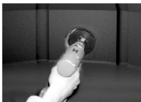
Рис. 10 Сверление отверстия для установки ЗПТ
