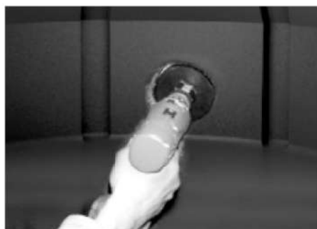
Рис. 10 Сверление отверстия для установки ЗПТ
