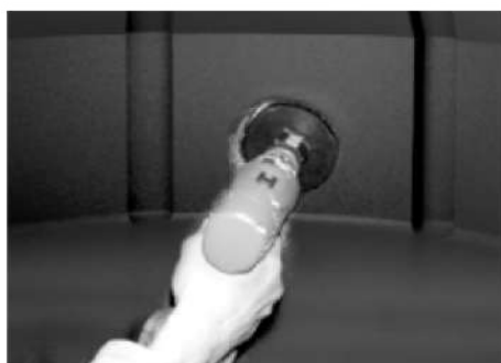
Рис. 10 Сверление отверстия для установки ЗПТ
