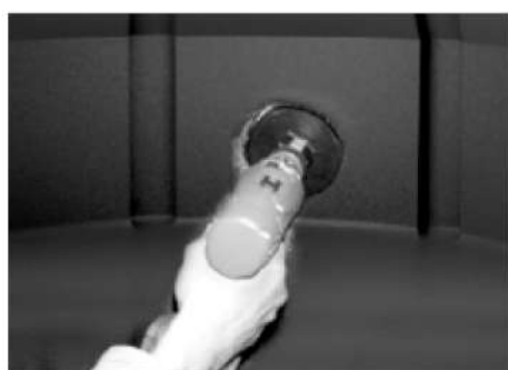
Рис. 10 Сверление отверстия для установки ЗПТ
